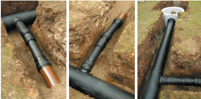
Distribución por canalización. Fuente: PLASSON
